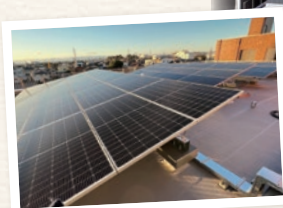
太陽光発電の設置
